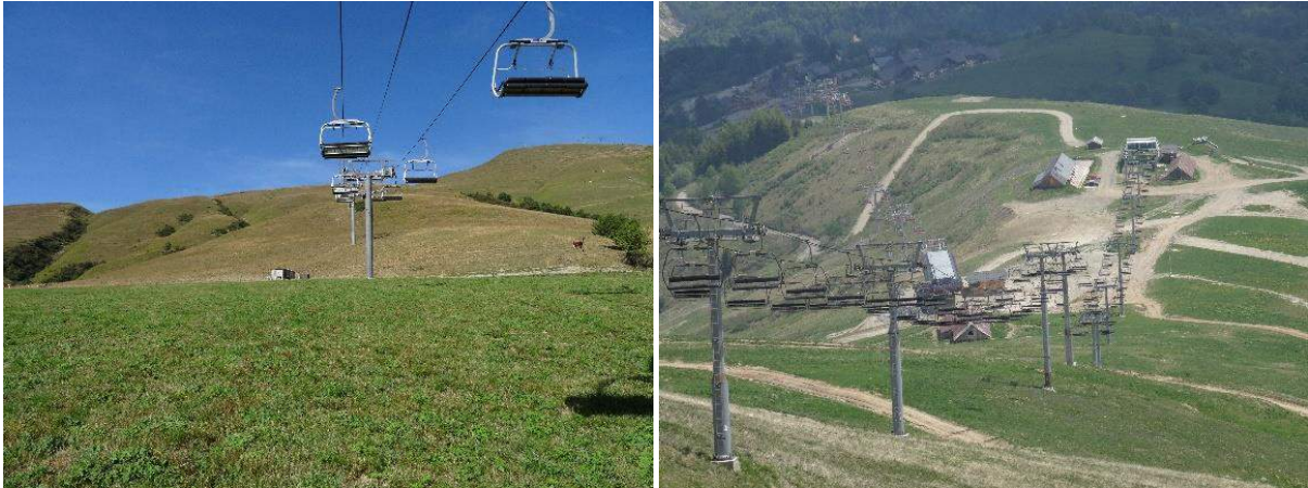
Appareil en vue de démolition
