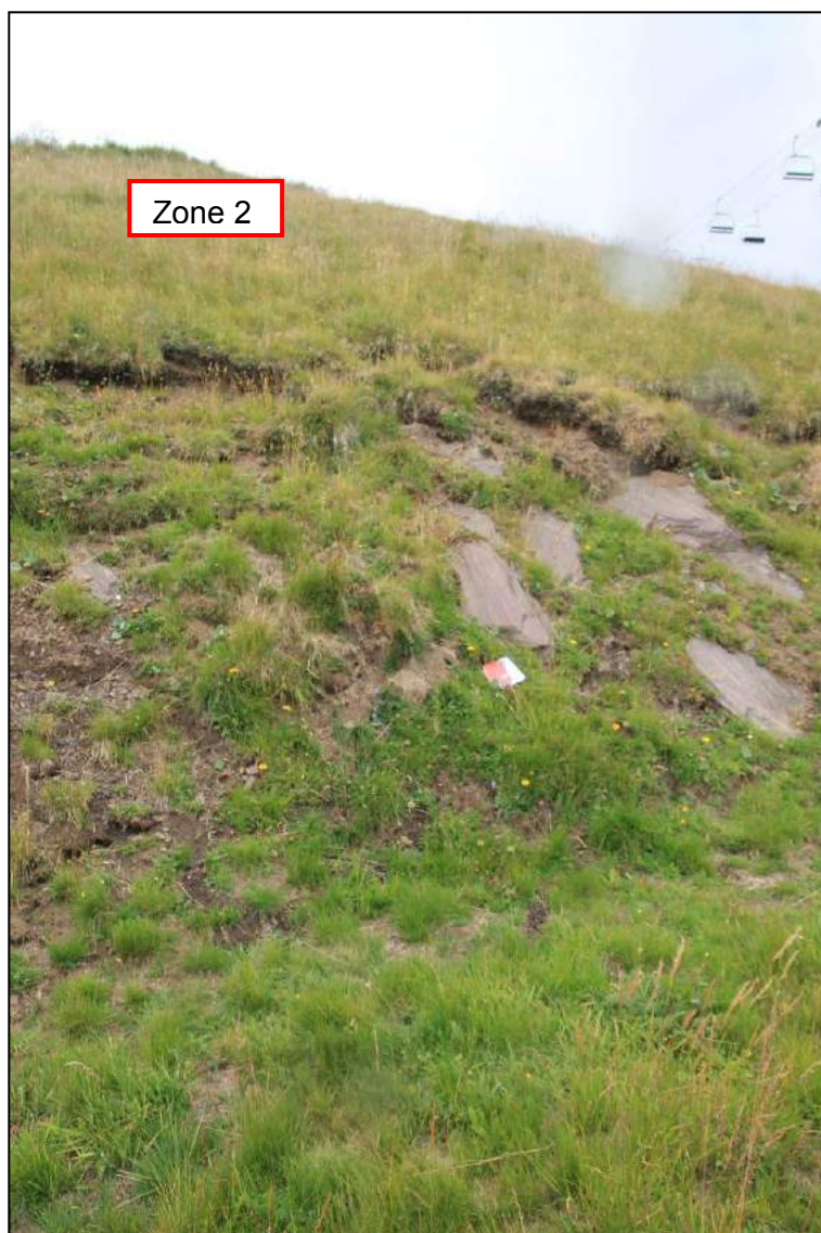
Vue du talus amont de la risberme et zone n°2 à l'amont
