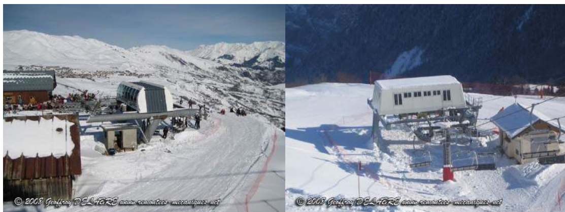
Clichés (remontées-mécaniques.net) des gares de départ du Corbier et de l'Épaulle du Corbier
