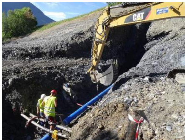
fosse pour la canalisation AEP Lyonnaise 04/07/16
