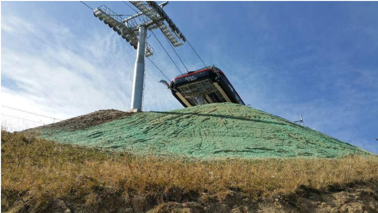
Installation toile coco et revégétalisation le 14 octobre 2016 sous la G2 Voie Lactée
